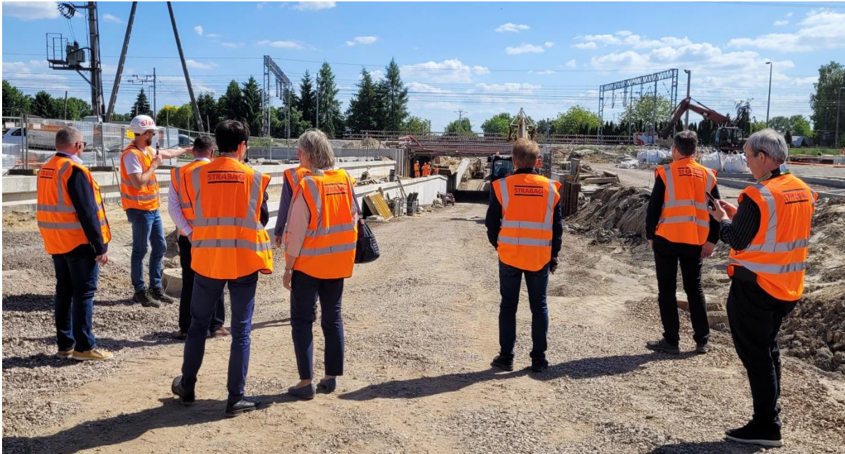
Uczestnicy na terenie budowy tunelu pod magistralą kolejową w Koluszkach (fot. A. Kasztelewicz)
